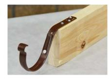
1.5 Если шаг кронштейнов не совпадает с шагом стропил, прямой удлинитель или металлический кронштейн закрепите прямо в деревянное основание в заранее подготовленные углубления
