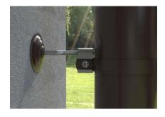
Трубы к стене крепятся при помощи хомутов. Предварительно подготовьте под них крепеж в соответствии с отступом от фасада и толщиной теплоизоляции. Крепеж должен заходить минимум на 50 мм в несущую конструкцию. Хомуты крепятся с шагом не реже, чем 1,5 м друг от друга. Хомут должен обязательно фиксировать колено, которое прижимает трубу к фасаду.
