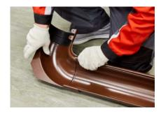
5.1 Если угол поворота кровли не равен 90° или 135°, используйте угол регулируемый. После выставления нужного угла две составные части зафиксируйте между собой клепками, а стык загерметизируйте.
