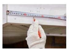
1.1 Зафиксируйте первый кронштейн. Кронштейн, ближайший к воронке, зафиксируйте с учетом уклона и протяните шнур между этими кронштейнами. По шнуру выставите остальные кронштейны с шагом 60–70 см.
