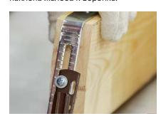
**1.3** Боковой удлинитель закрепите на готовую кровлю к боковой поверхности стропильной ноги.
