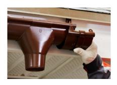
4.1 В кронштейны уложите желоб с воронкой изнутри наружу. Зажмите фиксаторами при помощи специального ключика, который идет в комплекте.
