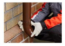
9.1 Минимальное расстояние слива от земли — 20 см, при наличии отмостки — 15 см от уровня отмостки. Слишком низкое расположение водосточного слива к земле повышает риск образования наледи внутри трубы, что может ухудшить работоспособность всей системы и привести к разрыву трубы.
