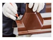
3.1 Вырежьте отверстие в желобе при помощи ножовки по металлу и ножниц по металлу. Соедините воронку с желобом и зажмите фиксаторы.
