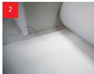
Раскатайте рулон LOGICROOF NG вдоль стенки люка дымоудаления. Край полотна должен подходить вплотную к стенке.
