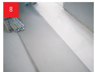
Далее разверните LOGICROOF NG и приварите следующий край аналогичным образом. Повторяйте процедуру до тех пор, пока не приварите всё полотно материала с шагом 200 мм.
