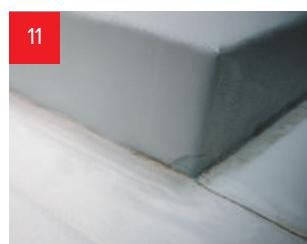
Готовая противопожарная рассечка вокруг люка дымоудаления.
