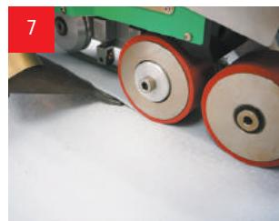
Осуществляйте приварку LOGICROOF NG полосами при помощи автоматического оборудования. При сварке избегайте пережогов и недогрева свариваемых материалов.
